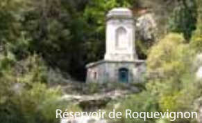
Réservoir de Roquevignon
