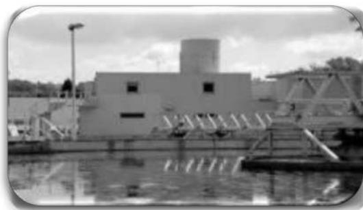
Cette usine a été construite et mise en service dans les années 80 et a connu ensuite dans les années 90 et 2010 différentes modifications permettant de s'adapter aux nouvelles réglementations et d'anticiper les évolutions de population. Elle a une capacité de 52 000 équivalents habitants et un débit de référence de 10 200 m<sup>3</sup>/j.
