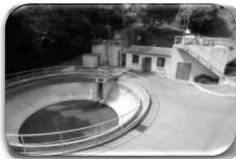
La station construite en 1975, a été remplacée par une nouvelle installation en septembre 1997. Sa capacité maximum est de 1 900 équivalents habitants et un débit de référence de 426 m<sup>3</sup>/j (arrêté préfectoral).
