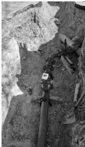
Les travaux ont consisté en un remaillage des réseaux d'eau potable et en la suppression d'une ancienne conduite qui passait en propriété privée au niveau du chemin Daou Ribas (du n°253 au n°479) sur la commune de Spéracèdes. Ainsi les travaux réalisés comprenaient :
