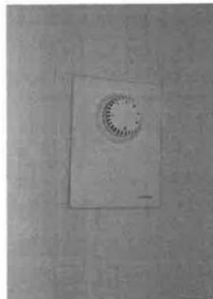
La régulation de l'installation de chauffage se fait pièce par pièce en fonction de la consigne de température fixée par les utilisateurs et de la température ambiante réellement mesurée dans la pièce.
